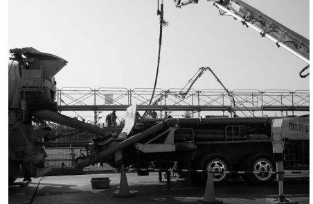
更新工事中の「上坪浄水場」
