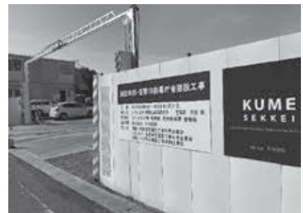
消防本部建替え工事
