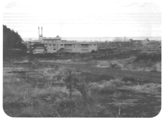
和田町常陸海浜公園線 (船窪区画整理地内)
