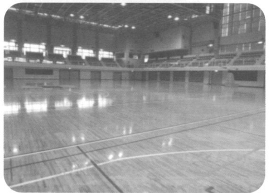
体育施設整備事業 (総合体育館床工事)
