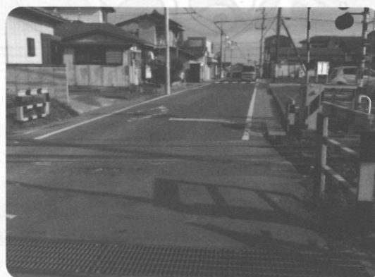
平磯2号雨水幹線整備予定地
