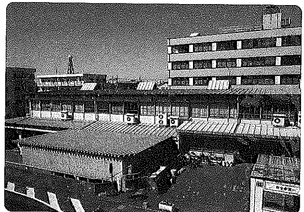
新分庁舎建設予定地、市役所北側の現業棟
