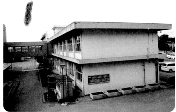
耐震補強工事予定の佐野小
